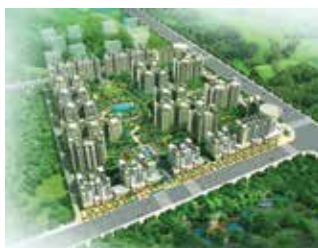
偉業氧立方 A 三期 (其一及二期已竣工)
